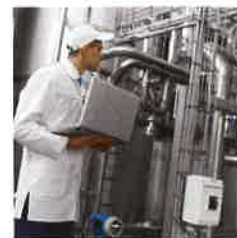
Capturs et logiciels complètent l'inspection de l'installation.
